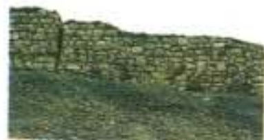
Castro de Campa Torres. Detalle de la muralla donde se puede apreciar la unión de dos módulos constructivos. Delante de la muralla se observan en el suelo grandes manchas negras, huellas del incendio previo al levantamiento del conjunto defensivo.
