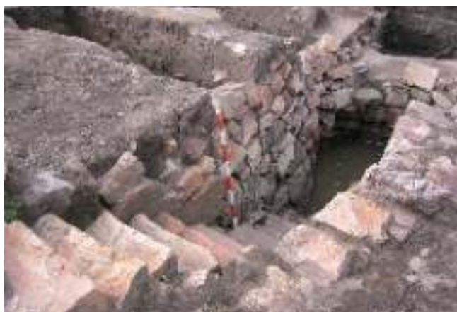
FOTO 4: Escalinata que conduce al fondo de la estructura. Encastros en la parte alta de los muros se han documentado fragmentos de téglula y ladrillo romano. (Foto Álvaro Menéndez).
