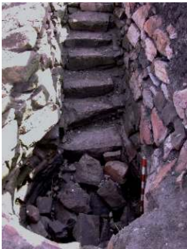
Foto 2: Imagen del interior del pozo parcialmente colmatado por mampuestos caídos de sus paredes.
